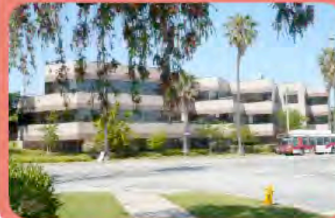
Wilshire Boulevard Los Angeles, CA
